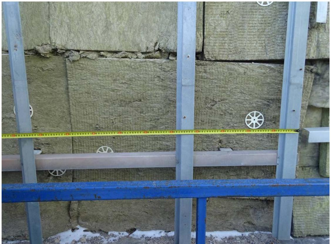
**Фото 10. Измерение шага вертикальных направляющих**
