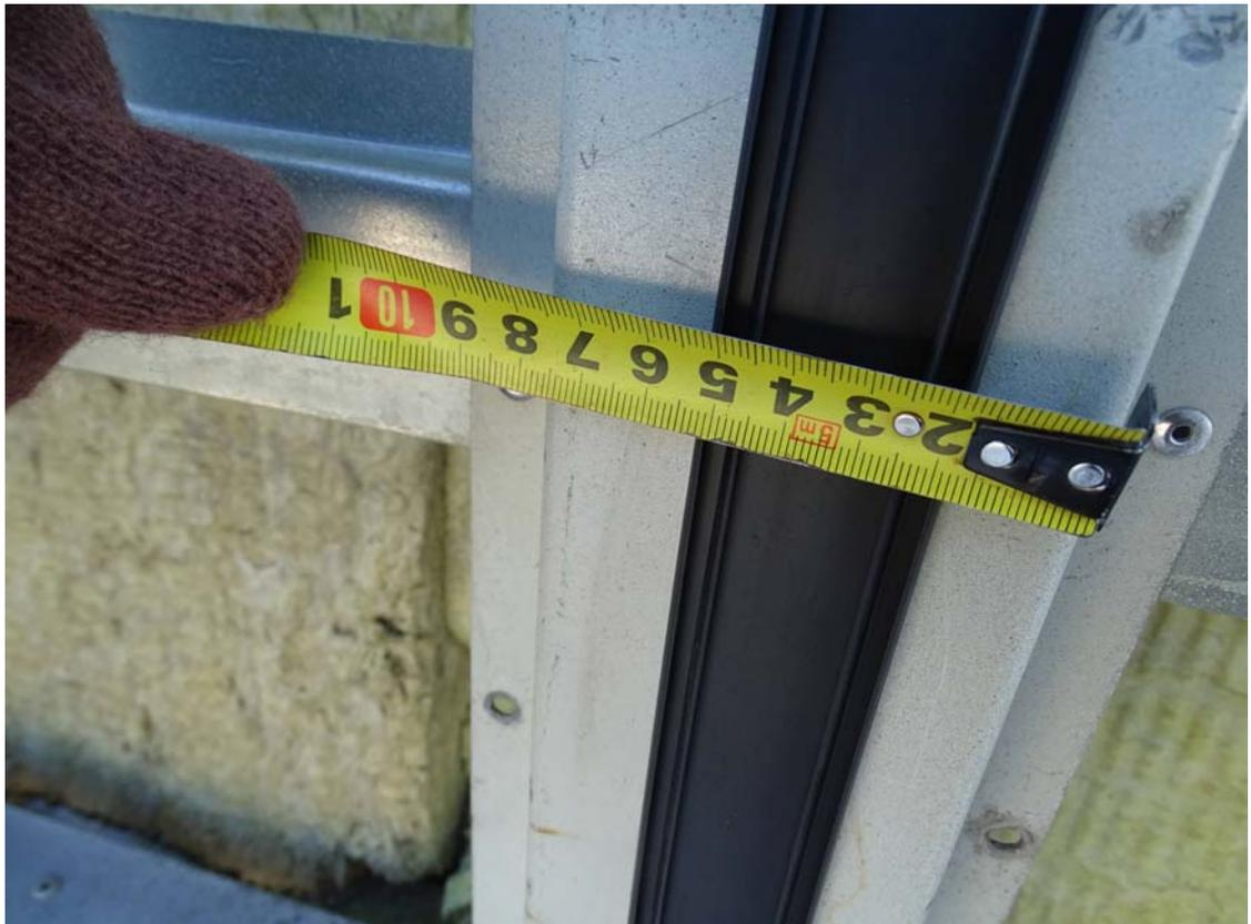
**Фото 9. Измерение ширины направляющего профиля**
