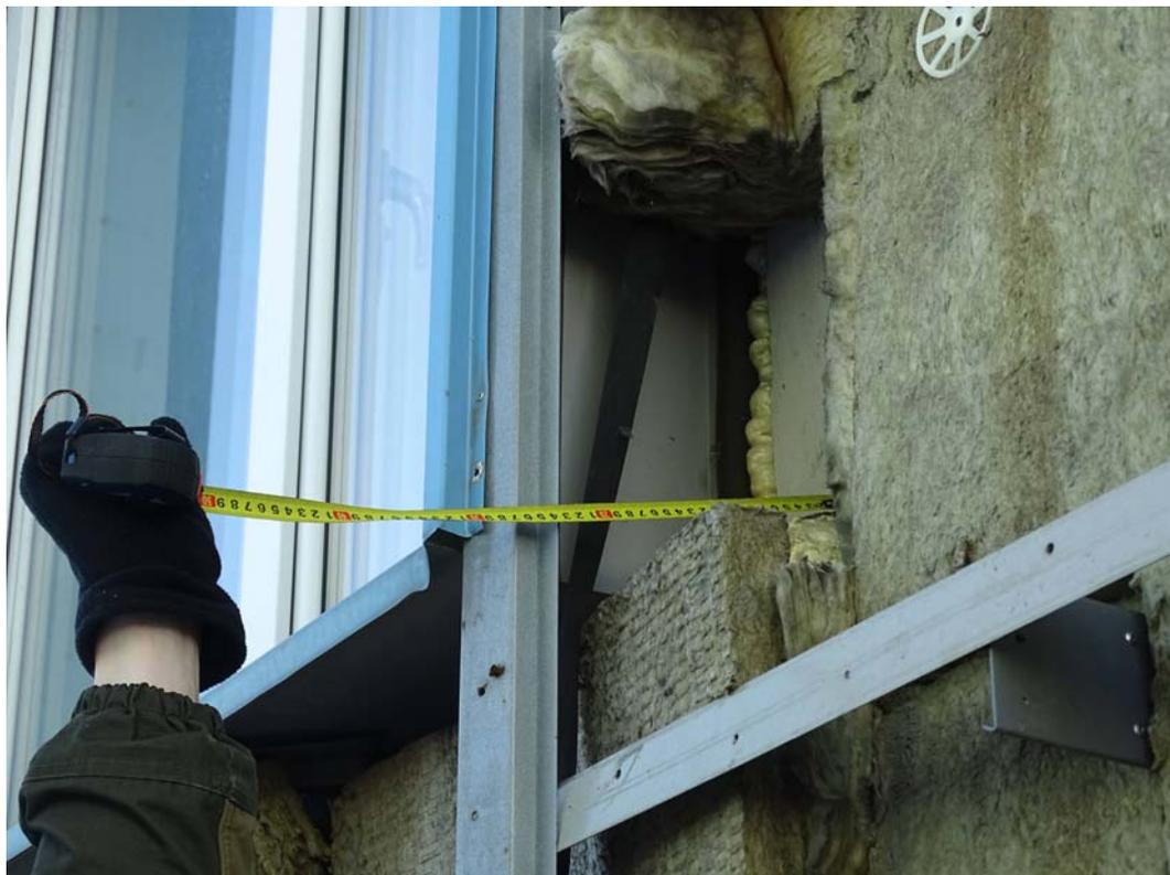
**Фото 11. Измерение толщины системы навесного вентилируемого фасада**
