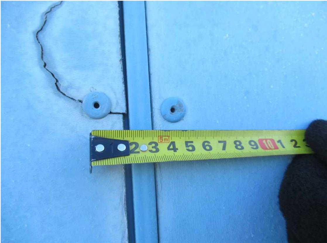
Фото 13. Измерение расположения заклёпок
