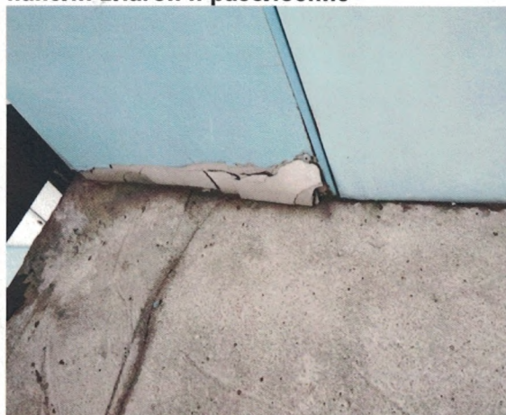
Фото 12. отсутствие крепления
