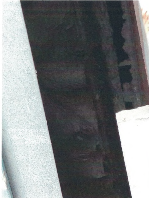
Фото. 5 Отсутствие утеплителя
