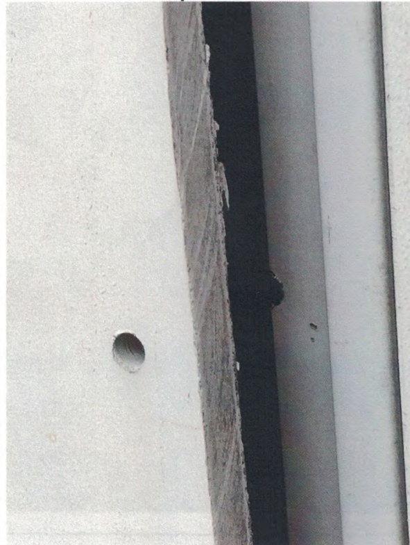
Фото 4. результат не регламентного крепления панели – отслоение панели от металлического каркаса
