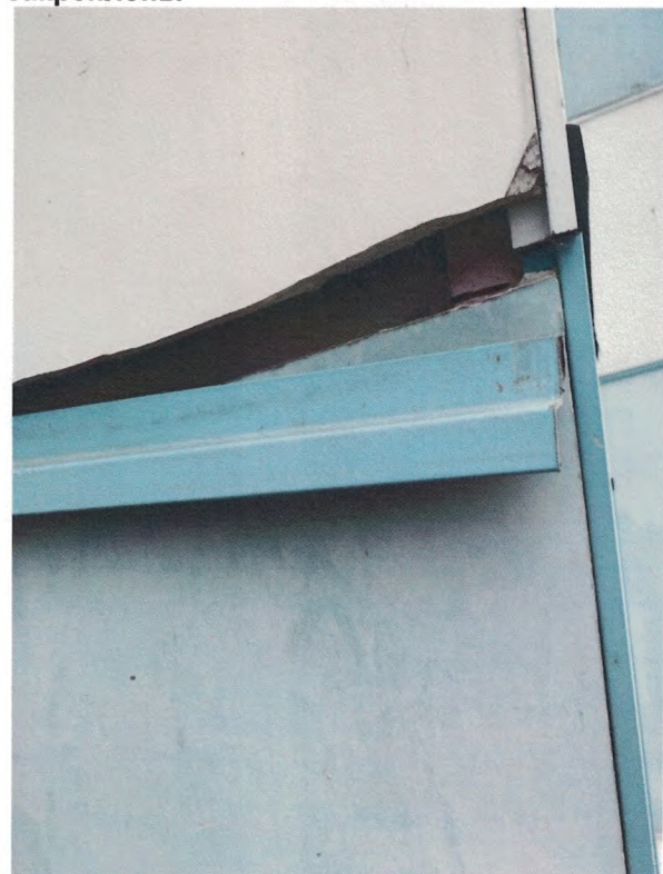
Фото 7. детали фасада никак не закреплены
