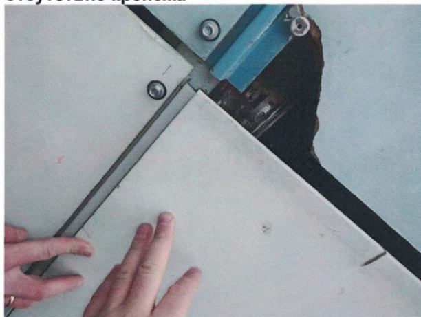
Фото 11. отколы и отсутствие креплений панели
