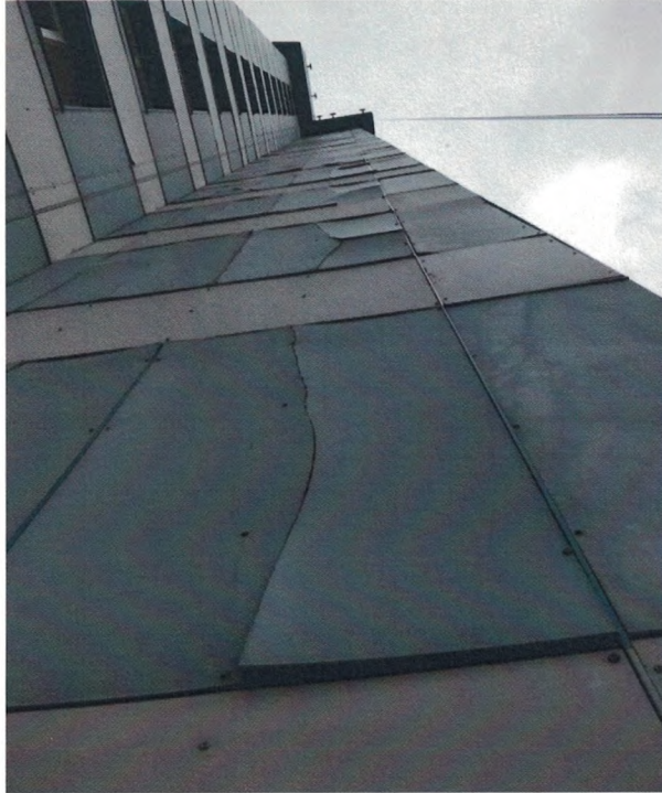
Фото 3. отсутствие технологических зазоров не проектное расположение крепежа
