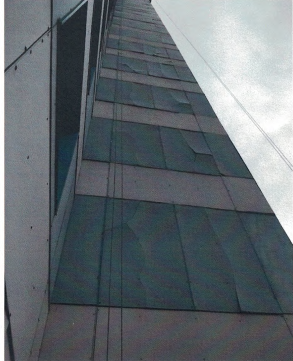
Фото 4. результат не регламентного крепления панели – отслоение панели от металлического каркаса
