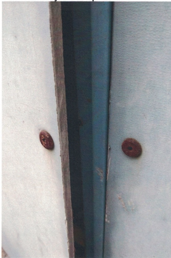
Фото 12. отсутствие крепления
