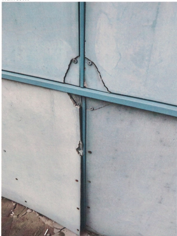
Фото 11. отколы и отсутствие креплений панели
